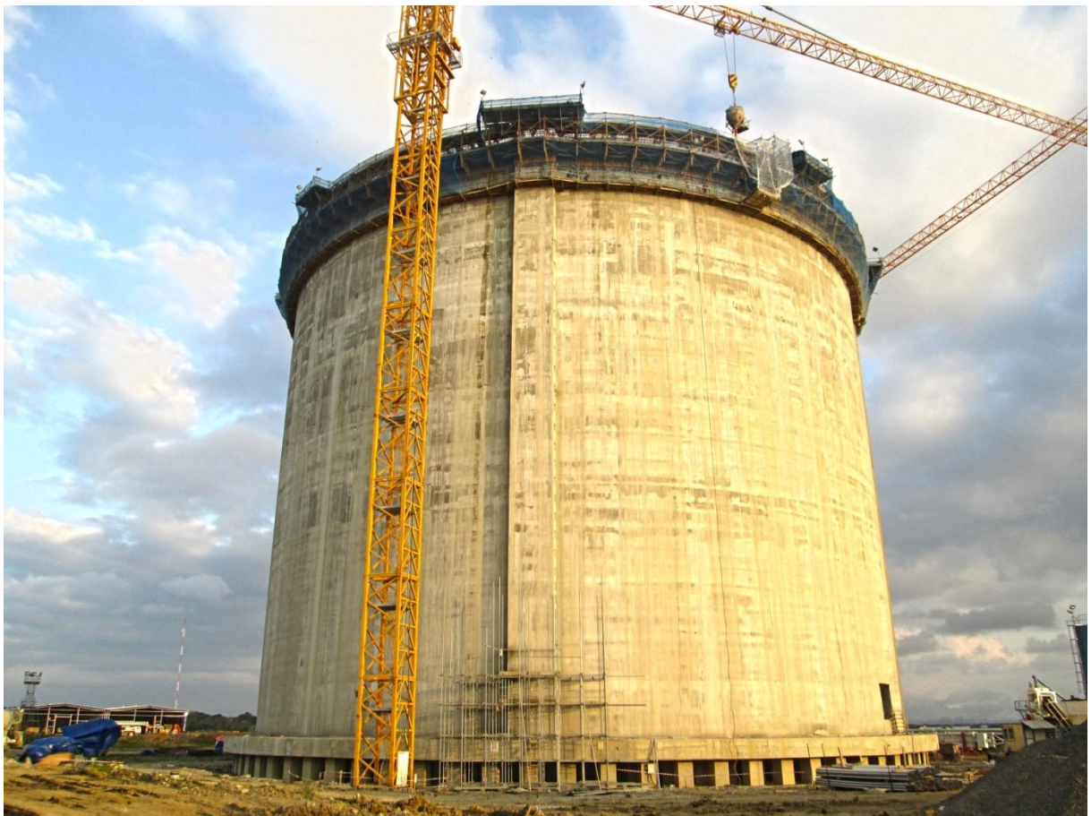
Après la construction des murs
