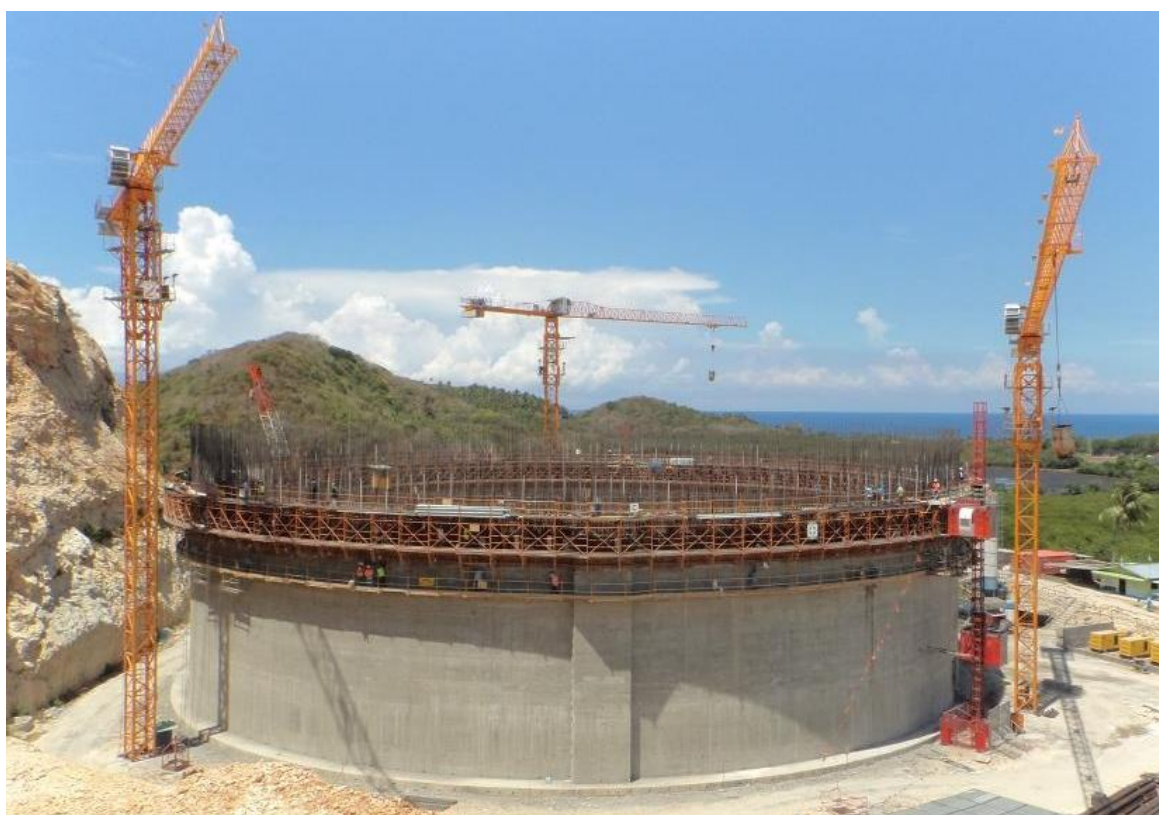
Pendant la construction des murs
