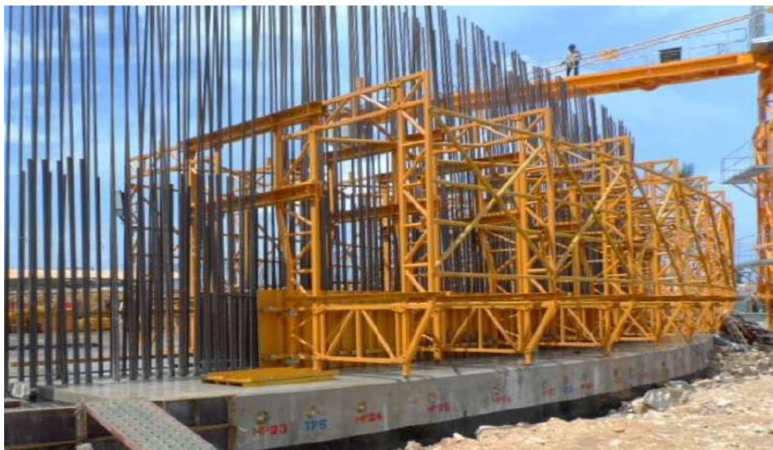
Dalle et coffrage
